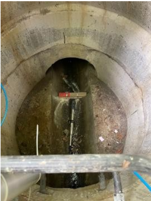
Abbildung 20: Einrichtung einer Blende für Wasserspiegelmessungen im Zulauf der GSA Mühlbach (Quelle: B. Monai).
