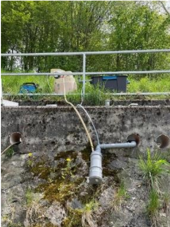
Abbildung 19: Einrichtung des Bypass im Zulauf der GSA Mühlbach (Quelle: B. Monai).
