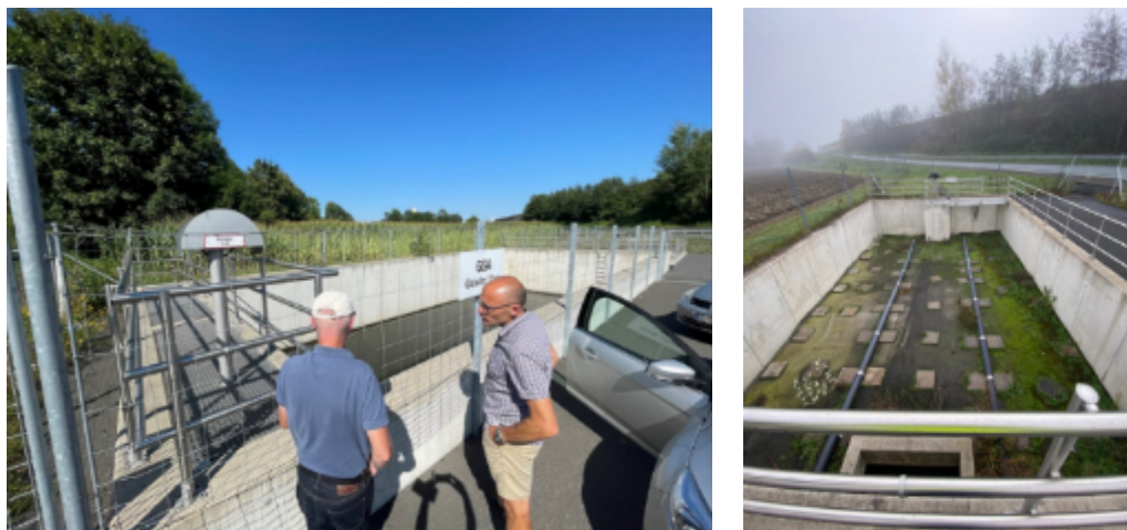
Abbildung 10: Bilddokumentation der GSA A2 Südbahn, Ast Gleisdorf West (Quelle: Umweltbundesamt).
