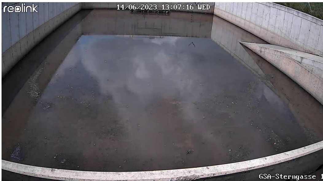
Abbildung 52: Absetzbecken am 14.06.2023, knapp vier Tage nach dem letzten Niederschlag.
