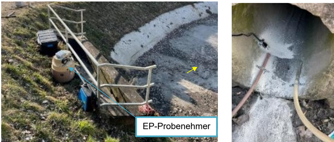
Abbildung 23: Einrichtung des Zulaufs der GSA Mühlbach (Quelle: B. Monai).
