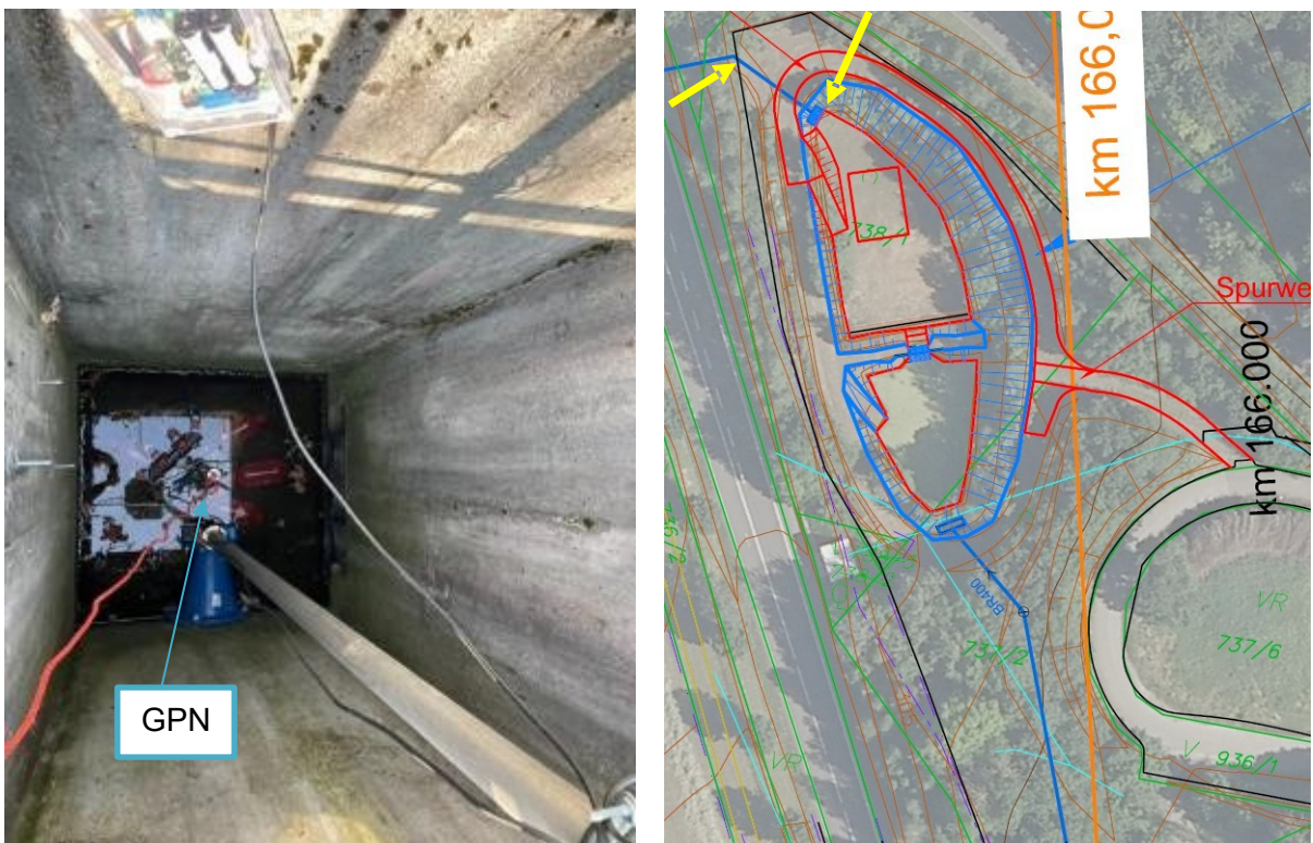
Abbildung 24: Einrichtung der Probennahmesysteme im Ablauf der GSA Mühlbach (Quelle: B. Monai).
